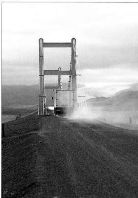
Landstungan við Breiðamerkurlón sem brúin spannar, er veikasti hlekkur hringvegarins.
