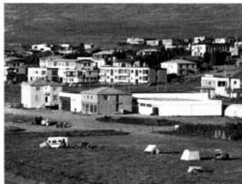
Dýrt er að byggja heilsugæslu, lögreglustöð o.s.frv. fyrir hverja 200 íbúa
